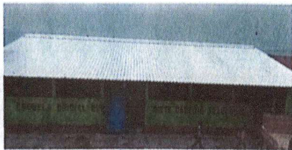
Foto 1: Sustitución de lámina por lámina troquelada aluzino calibre 26
