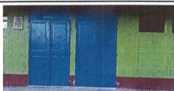
Foto 4: Sustitución de puerta doble
